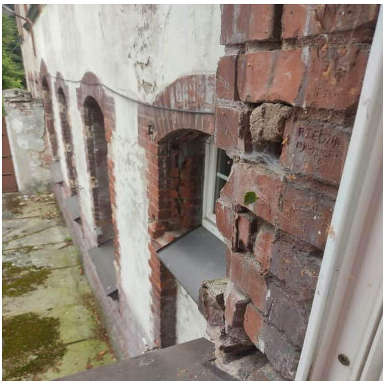
Fot. 10. Fragment okucia okiennego - otwory w ceglach w po dawnych kratkach
